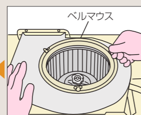
シロッコファンのベルマウスを取り付けネジ3ヶ所を手でははずし、ベルマウスをはずす。
