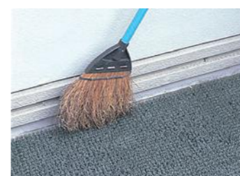
床と壁の間にゴミがたまると、排水を妨げ縦樋の詰まりの原因になるので、こまめに取り除くこと。
