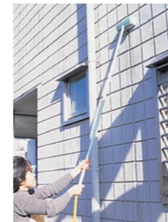
外壁を洗うには、ホースをつなぎ、水をかけながら洗えるブラシが便利。
