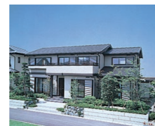
外壁は年2回、キズ・カビをチェンジ。定期的な塗り替えが必要で、長くとく美しく保つことが大切です。(住宅タイプによって塗り替え不要)
