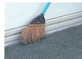
床と壁の間にゴミがたまると、排水を妨げ縦樋の詰まりの原因になるので、こまめに取り除くこと。
