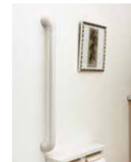
I型手摺 便座から立ち上がる際など、主に垂直移動の際の体重を支えます。
