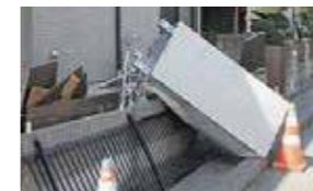
東日本大震災時の転倒例(セキスイハイムではありません) 出典:日経ホームビルダー2012年8月号
