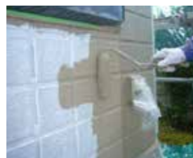
正しい塗布量で適切な施工
