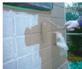
正しい塗布量で適切な施工
